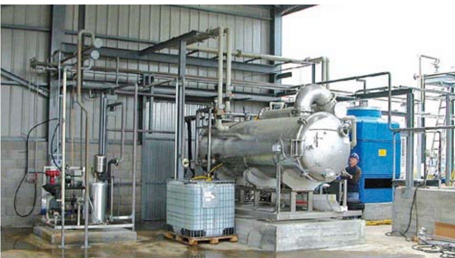
Durch die niedrige Verdampfungstemperatur von 30 bis 40 °C wird mit Vakuumverdampfern eine gute Destillatqualität erzeugt
