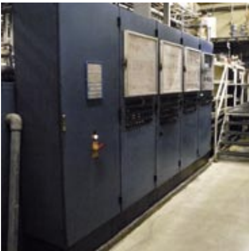
Der alte (links) und der neue Schaltschrank
